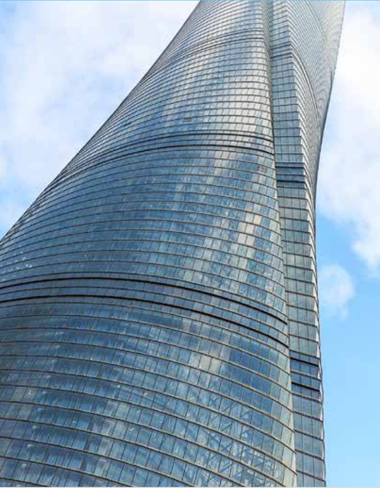
상하이 타워는 서로 겹쳐 쌓인 9개의 원통형 건물 형태이며, 양쪽 모두 접합유리로 구성된 더블스킨으로 둘러싸여 있으며, 내측 접합유리는 위로 올라가며 120° 비틀리는 형태를 완성한다. 이 설계로 건물의 풍하중이 24% 감소한다.
