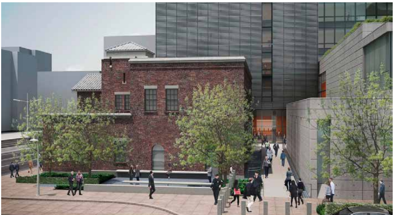
外面ファサードの大部分は、セントリグラス®アイオノマー樹脂製中間膜を使った防弾ガラスで構成されています。
