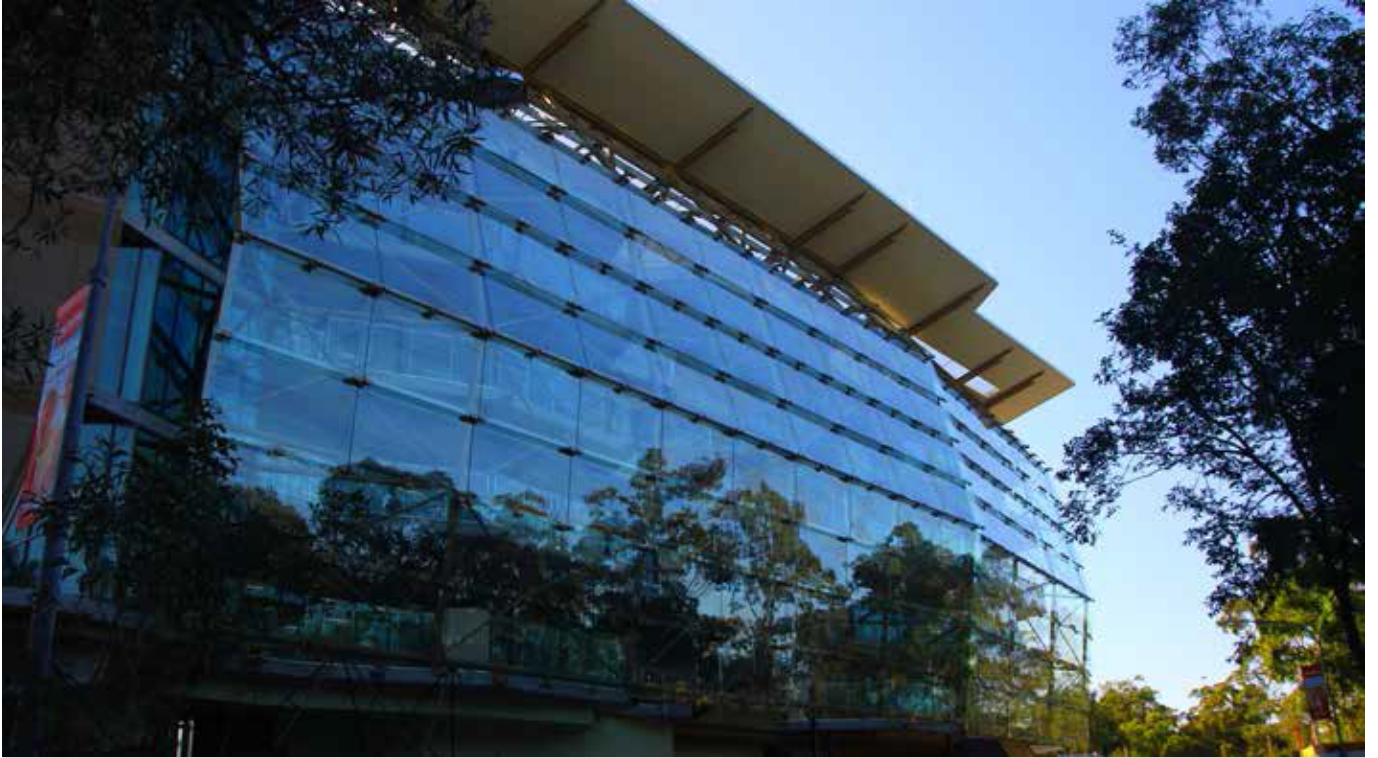
건물의 남쪽 면은 건물과 연결된 활 모양의 유리외벽으로 되어 있다. 이 외벽은 '빗물을 차단' 하는 역할을 하며 이로 인해 가장자리의 환기구에 자연스럽게 바람이 통하게 된다.
