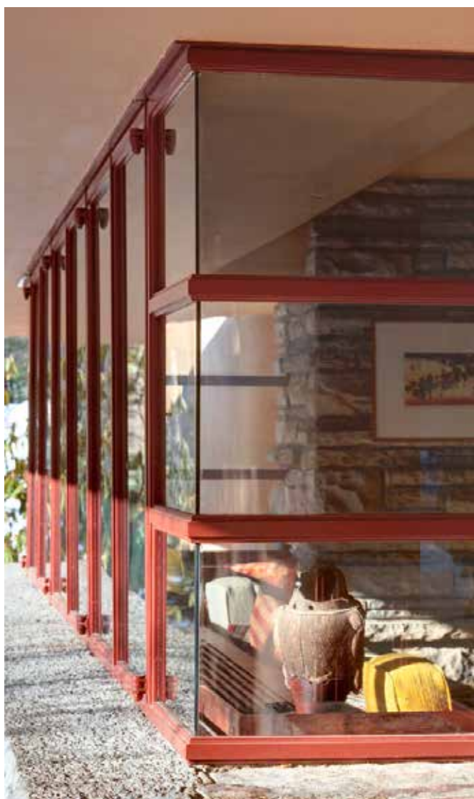
Znakomite zachowanie się krawędzi arkuszy SentryGlas® oznaczało, że architekt mógł zastosować spiny czotowe w miejscach styku paneli.
