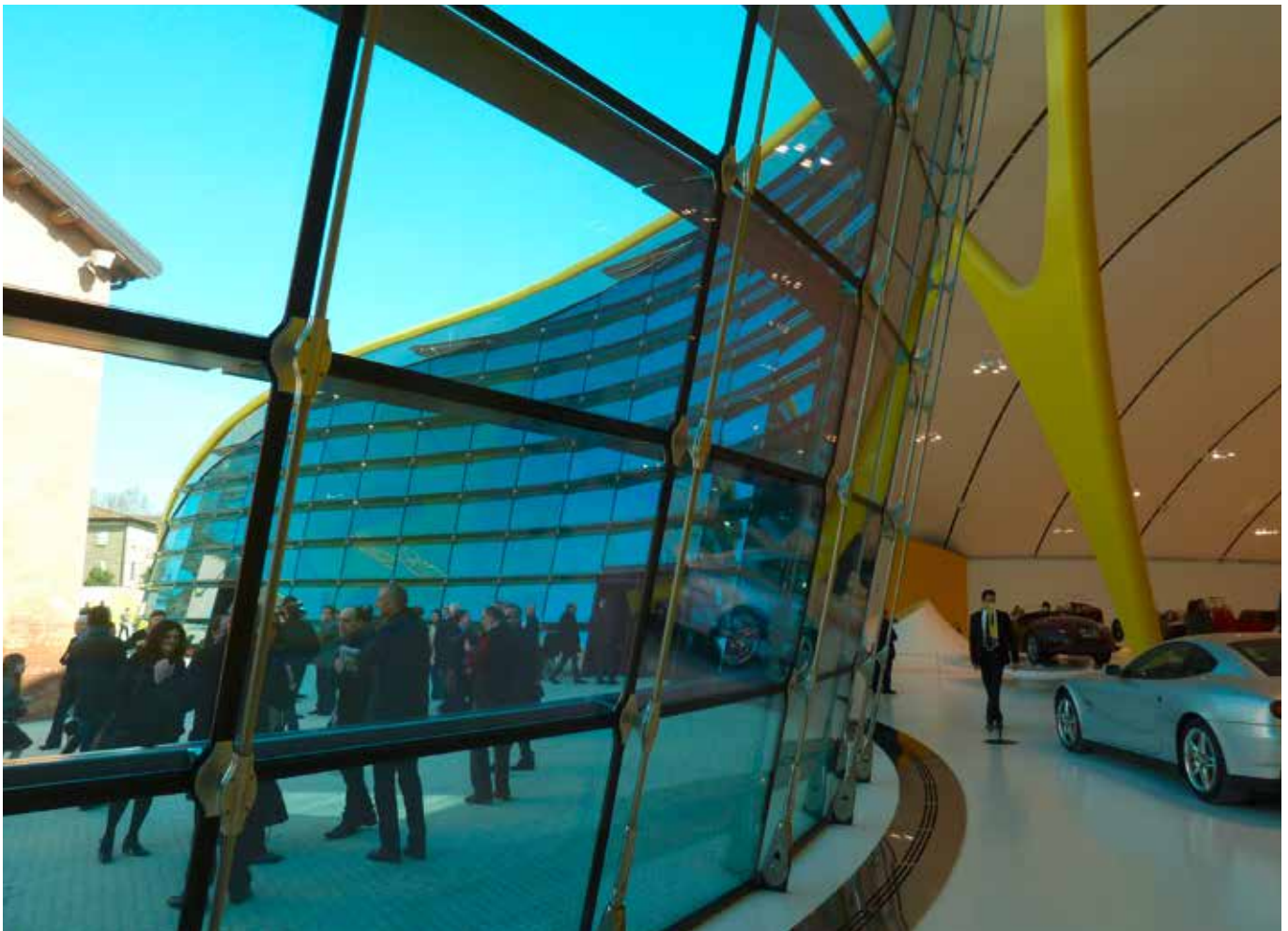
Eröffnung des Enzo Ferrari Museums. Die flachen Isolierglasscheiben werden von vertikal angeordneten Edelstahlspiral-seilen mit einem Durchmesser von 32 mm getragen. Sie bestehen aus außenliegenden, je 10 mm starken ESG-Glasscheiben und einem innenliegenden Verbund aus zwei mit Hilfe einer 1,52 mm starken SentryGlas® Zwischenlage miteinander laminierten, 6 mm starken TVG-Glasscheiben. Bild: Werner Sobek Stuttgart.
